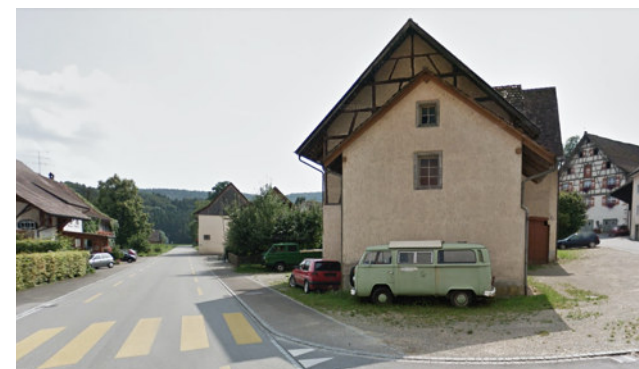
Ecke Hauptstrasse und Oberdorf, Blickrichtung Süden. Empfang mit einer geschlossenen "Rückfassade"; die freien Flächen um das Gebäude sind mit Autos besetzt.
