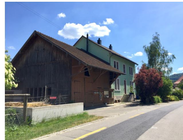
Einfamilienhaus kombiniert mit Landwirtschaftsgebäude
