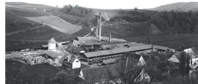
Die Ziegelfabrik Hofen um 1909, als sie 120 Mitarbeiter zählte.
